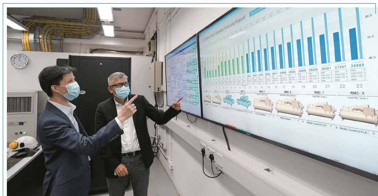
中電與香港機場管理局合作，設計及研發全港最大規模的電池儲能系統，及一個冷氣預調系統。
