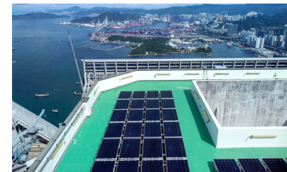
• 環球貿易廣場參與中電的「可再生能源上網電價」計劃，在天台安裝的100多塊太陽能光伏板每年產生約三萬度電
