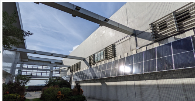
位於香港觀塘的東亞銀行中心天台共裝設40塊太陽能板，每年約可生產8,400度可再生能源。
