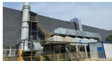
公司採用活性炭吸附脫附+催化燃燒、沸石轉輪+RTO的治理技術，提升塗裝廢氣處理效果，減少廢氣污染物排放量。購置風速儀，用於測定生產設備周邊風速風向，規範監測塗裝廢氣無組織排放量，滿足政府工業污染治理要求。
