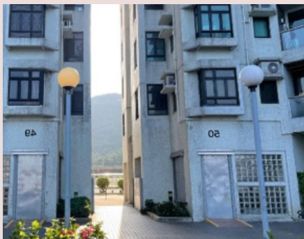
在靠近海岸和地庫停車場的建築物入口和機房安裝防洪閘。
