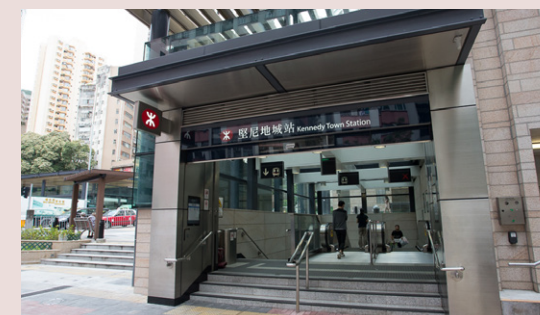
大部分港鐵站的出入口設計，最少高出街道地面450毫米，並配備1.2米高的防洪板。
