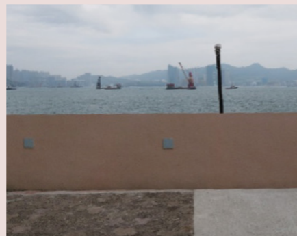
在杏花邨遊樂場建造花槽圍牆，以防止海浪湧入。
