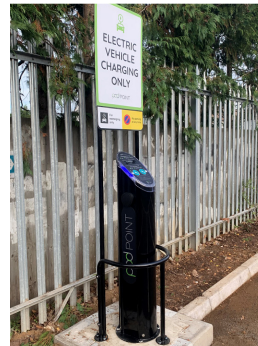
港鐵伊利莎伯綫在Gidea Park車廠安裝七個電動車充電站，方便員工在工作期間為電動車充電。
