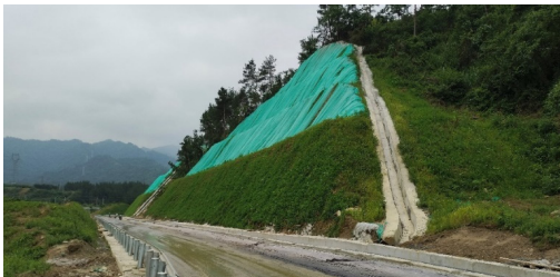
十堰项目进场道路边坡复绿
