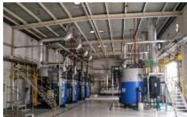
济南公司燃气锅炉低氮改造
