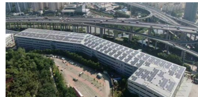
青岛啤酒二厂光伏项目
