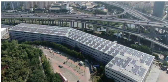
青島啤酒二廠光伏項目
