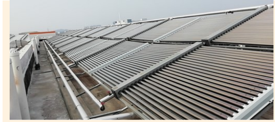
在中國南京，在最近建成的廠房房頂的太陽能熱水器，為整個宿舍提供熱水，減少能源消耗
