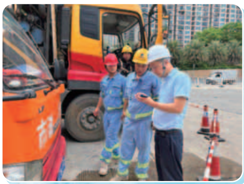
施工車輛專項檢查
