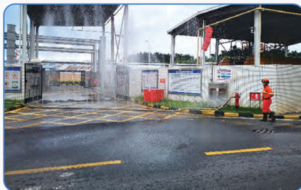
液氨泄漏應急處置演練
