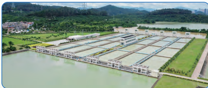
生物硝化工程全景
