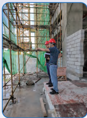
技術人員現場施工整改
