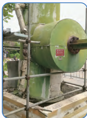
管線緊急搶修
