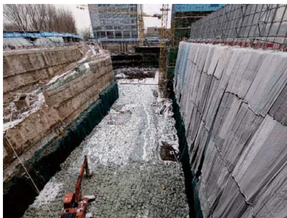
Winterized site 冬維現場
