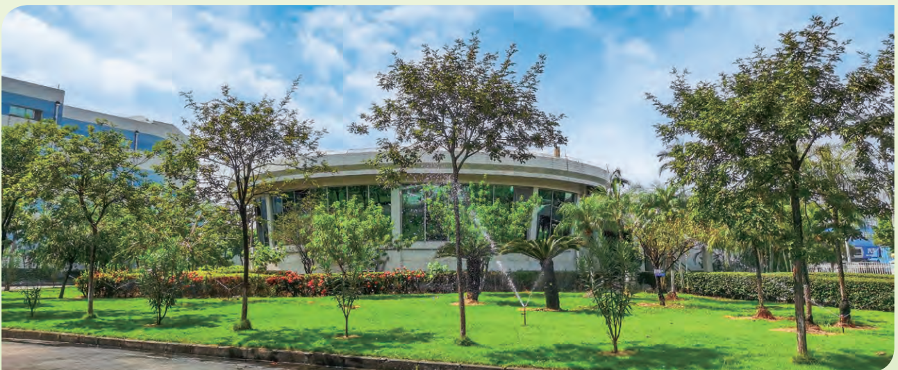
位於偉易達工廠的雨水收集系統
