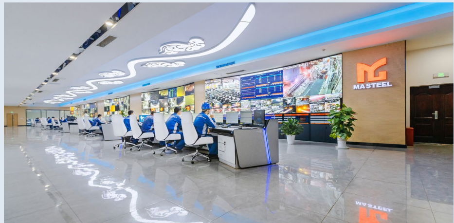
馬鋼智能 RH 控制系統：開創「一名主操同時操控兩座 RH 爐」的行業先河。
