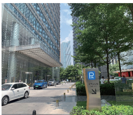
該物業的北面入口
