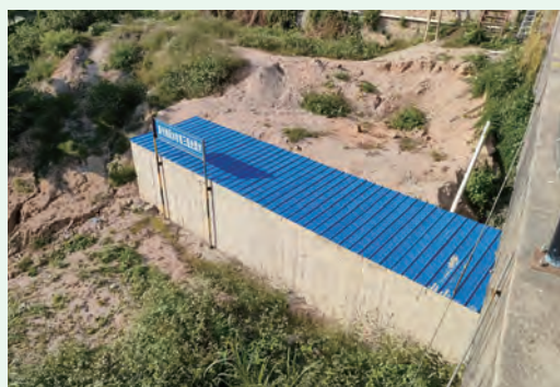
肇慶康州港利用碼頭內的雨水收集系統，收集水用於園林綠化或壓制灰塵，節約水資源。
