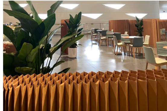
咖啡角围挡采用可循环瓦楞纸板
