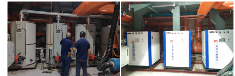
锅炉改造前后
