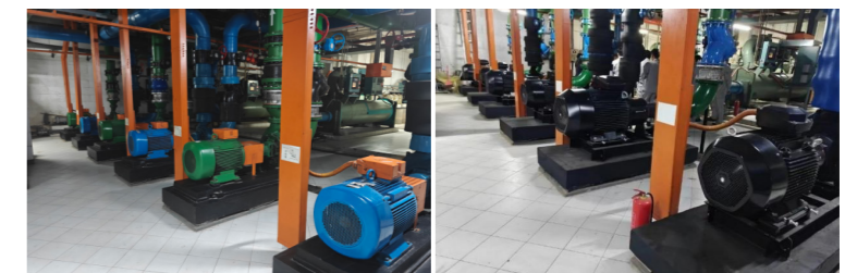
循环水泵改造前后
