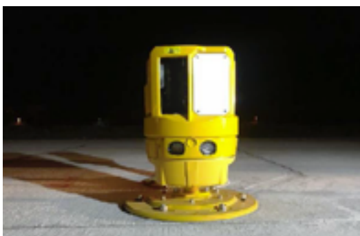
◆ 跑道外來物（FOD）探測系統項目施工現場
