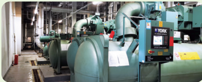
圖：約克離心機組進行變頻升級改造項目
