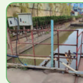
原料进厂道路旁设有雨污水沉淀池,用于原料仓道路冲洗
