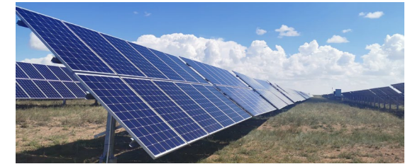
援建光伏村级电站
