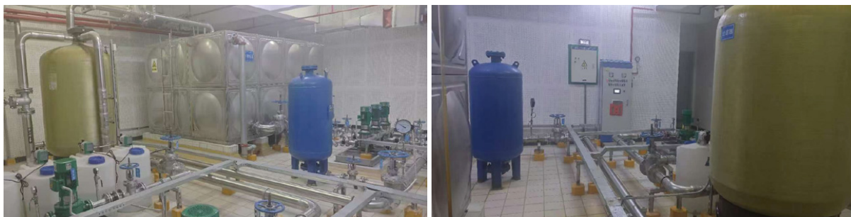
▲ 同程旅行大廈雨水回收系統
