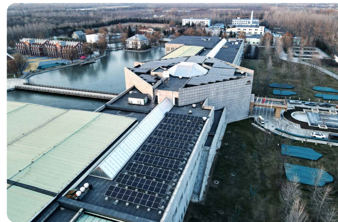
金茂怡生園酒店光伏發電系統
