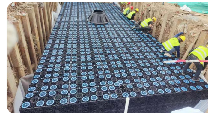
佛山朝安金茂悅加裝雨水模塊蓄水池施工現場
