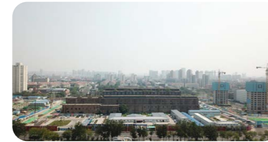
天津第一熱電廠改造前
