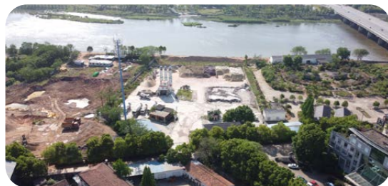
東湄片區改造前
