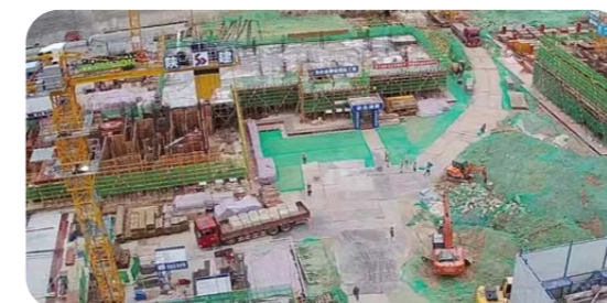
施工全程可視化
