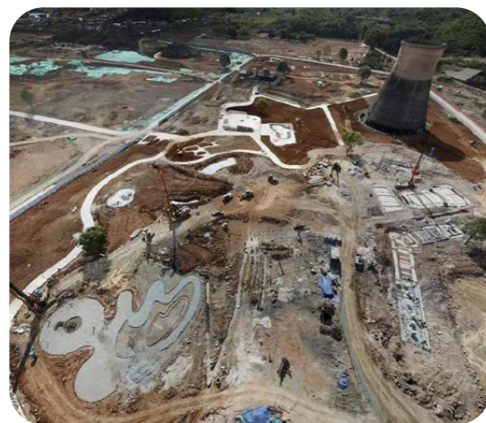
水晶化工一期治理後現場
