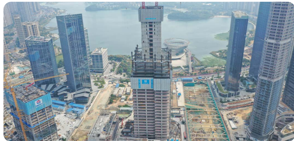
長沙金茂大廈建設現場
