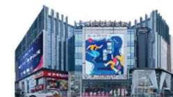
瀋陽津橋路時尚廣場
