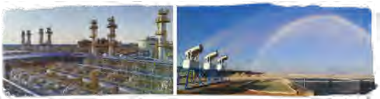
米桑油田終端廠水處理區域
