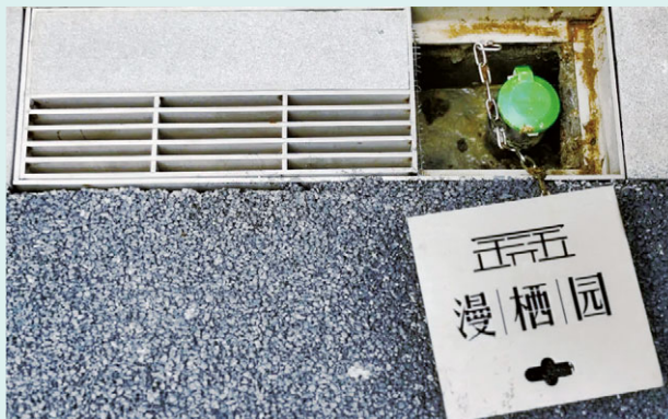
結合雨水口佈置綠化取水閥，實現雨水回用
