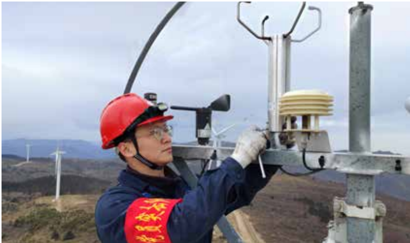
安裝加熱型超聲波氣象儀
