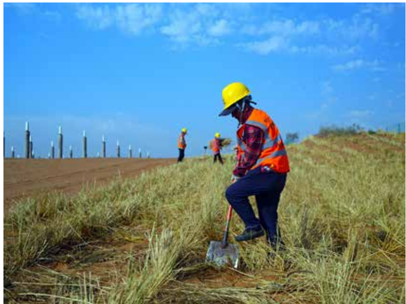
新能源項目建設同步實施草方格固沙生態修復
