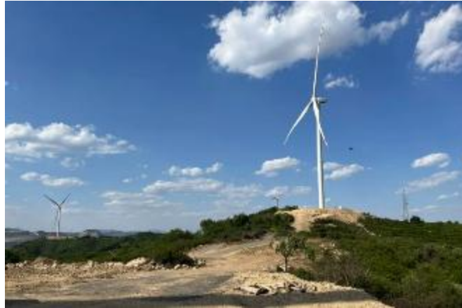
圖：山西陽泉孟縣支行支持建設的粵電鑫磊風力發電場
