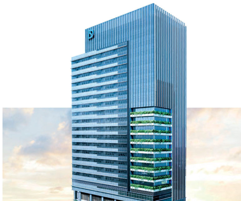
渠務署辦公大樓
