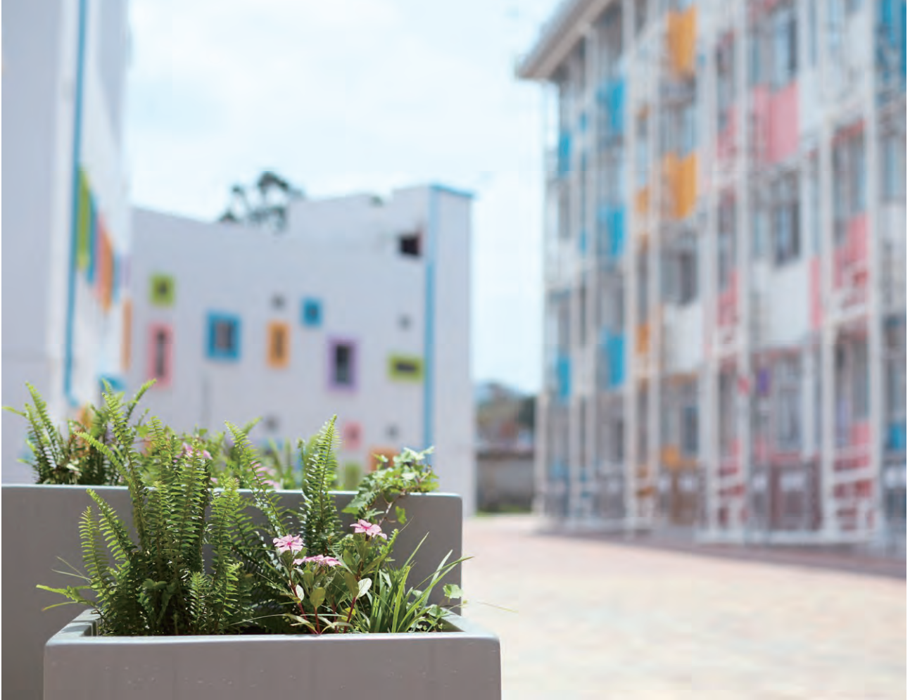
位於錦田的過渡性房屋項目「恒莆新苑」已竣工
