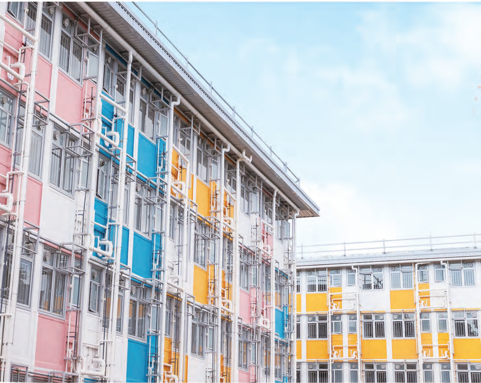
全面採用組裝合成建築法的項目
