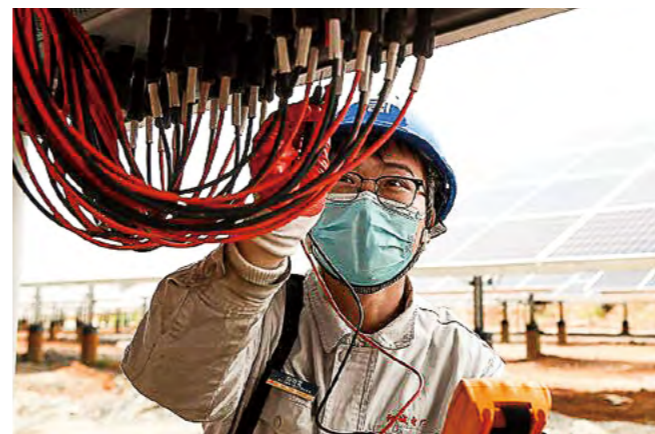
山西分公司开展光伏电站运维,确保安全稳定高效运行
