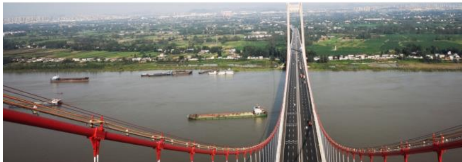
马鞍山长江公路大桥主缆
