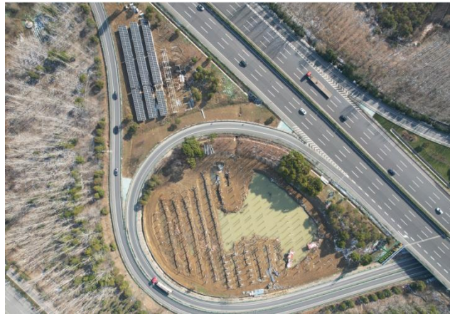
合肥绕城高速南环段光伏项目
