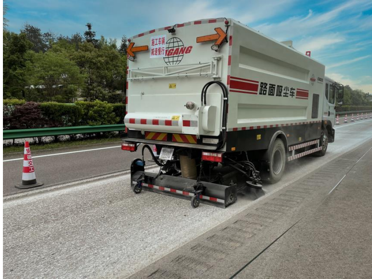
施工现场无尘清扫
