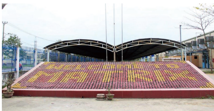
越南峴港市第三間廠房
