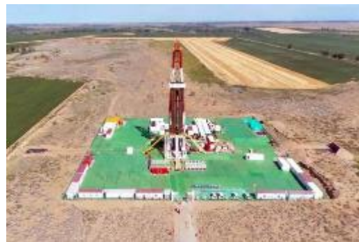
▲ 施工場所鋪設防塵網
