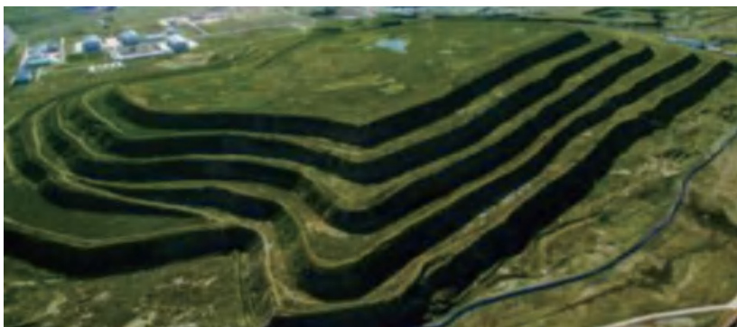
准能集团绿色矿山建设实景航拍
