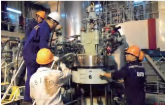
设备维修保养
