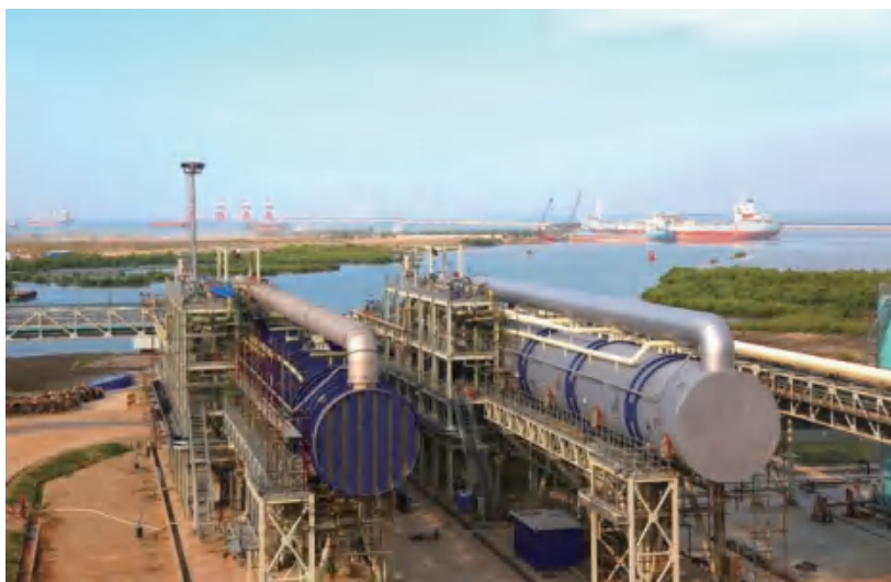
爪哇电厂海水淡化装置
