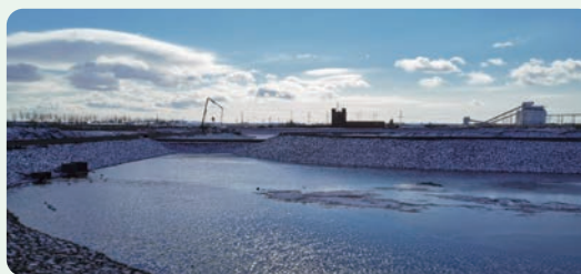
胜利能源蓄水工程
