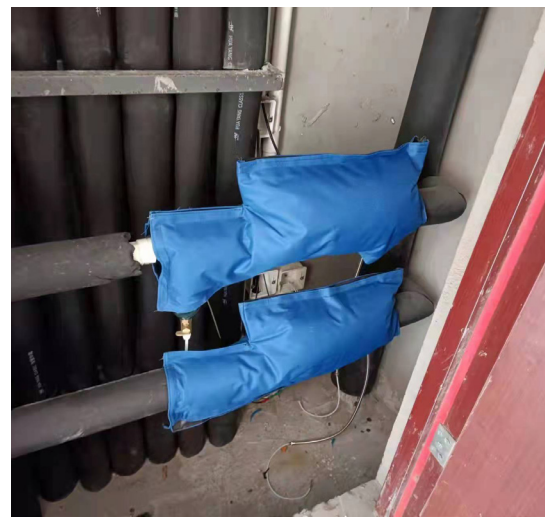
水管加裝電熱套
