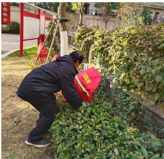
消防栓加裝保溫罩
