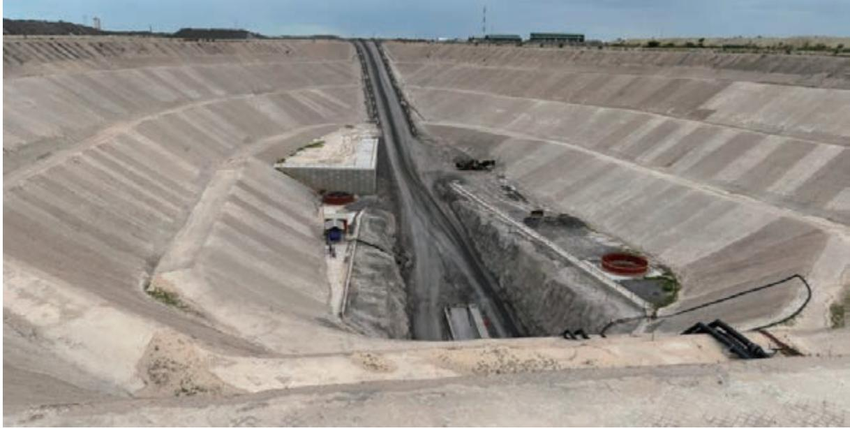
圖 11-2 顯示礦山通道和服務的 5 區開挖槽
