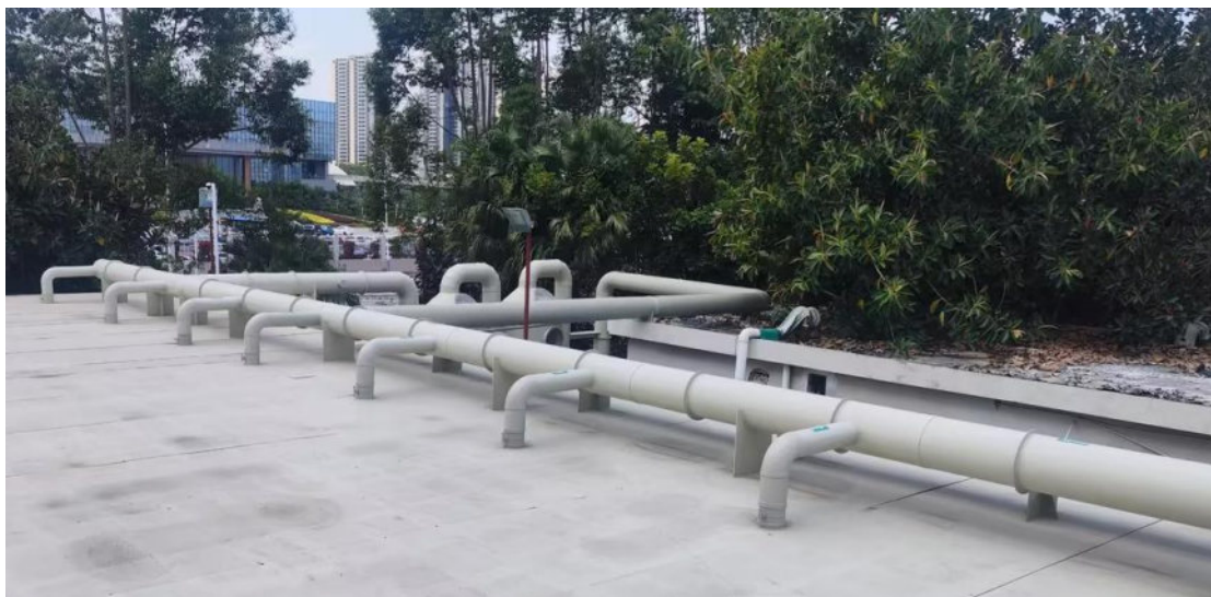
廢水站池體加蓋，減少氣體逸散
