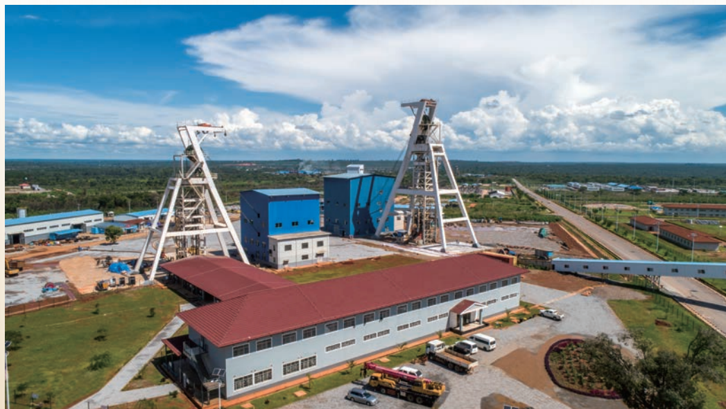
中色非礦東南礦體主、副井
