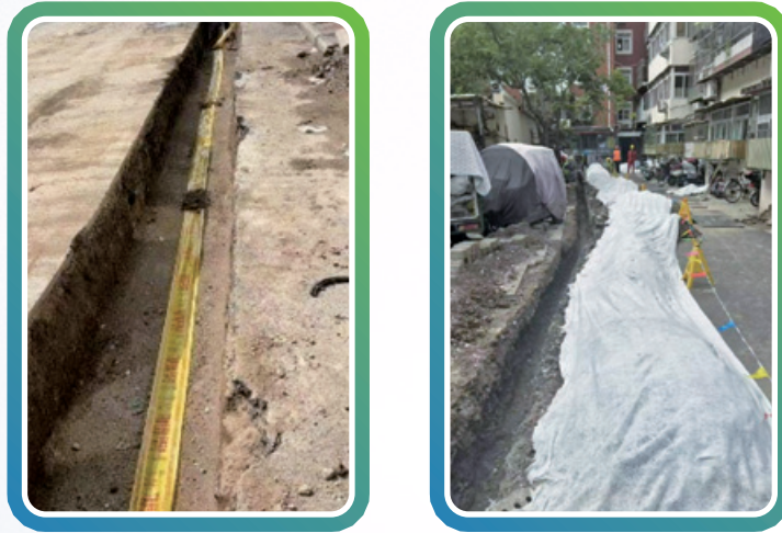
圖 舊管網改造工程環保措施
