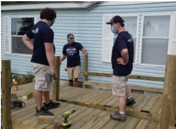
耐世特志願者為殘障人士修建坡道方便他們進出房屋
