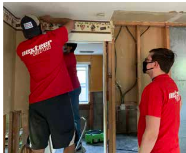
耐世特志願者協助整修受災房屋以便進行重建
