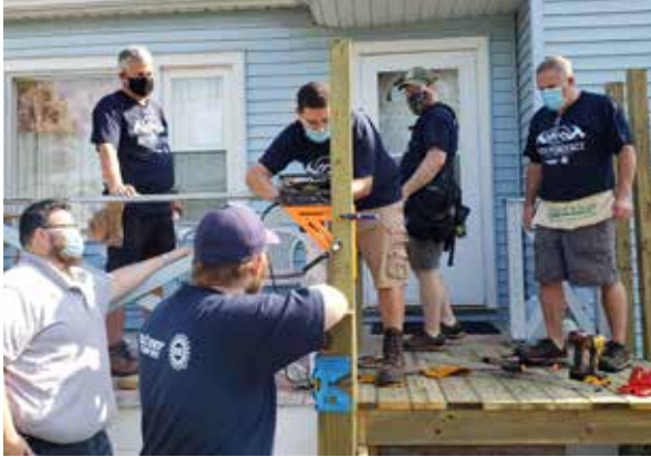
耐世特志願者為殘障人士修建坡道方便他們進出房屋
