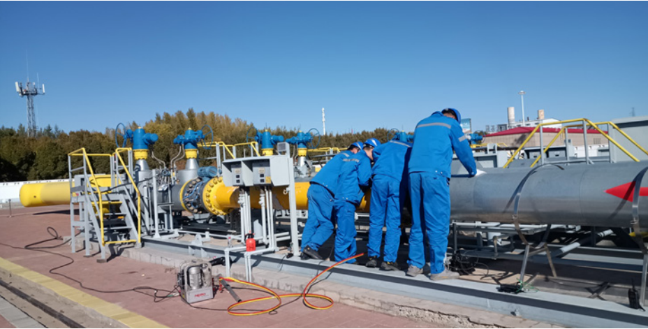
人保财险为中亚天然气管道项目开展专项防灾防损风险查勘服务
