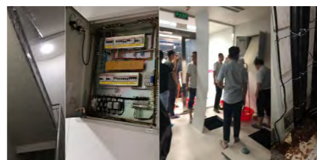
信息技术总部防汛抢险现场
