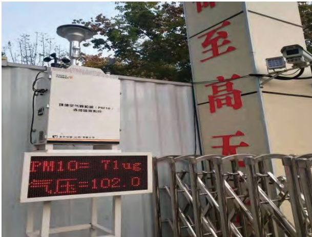
圖：污染控制措施－自動化噴淋系統
