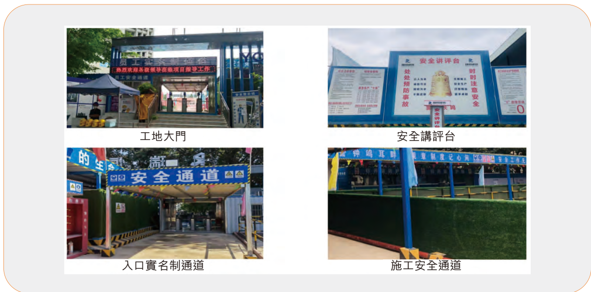
圖：安全生產 文明施工
