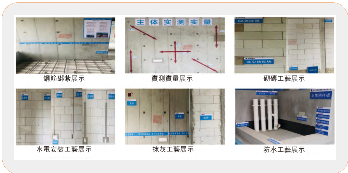
圖：施工工藝細節展示
