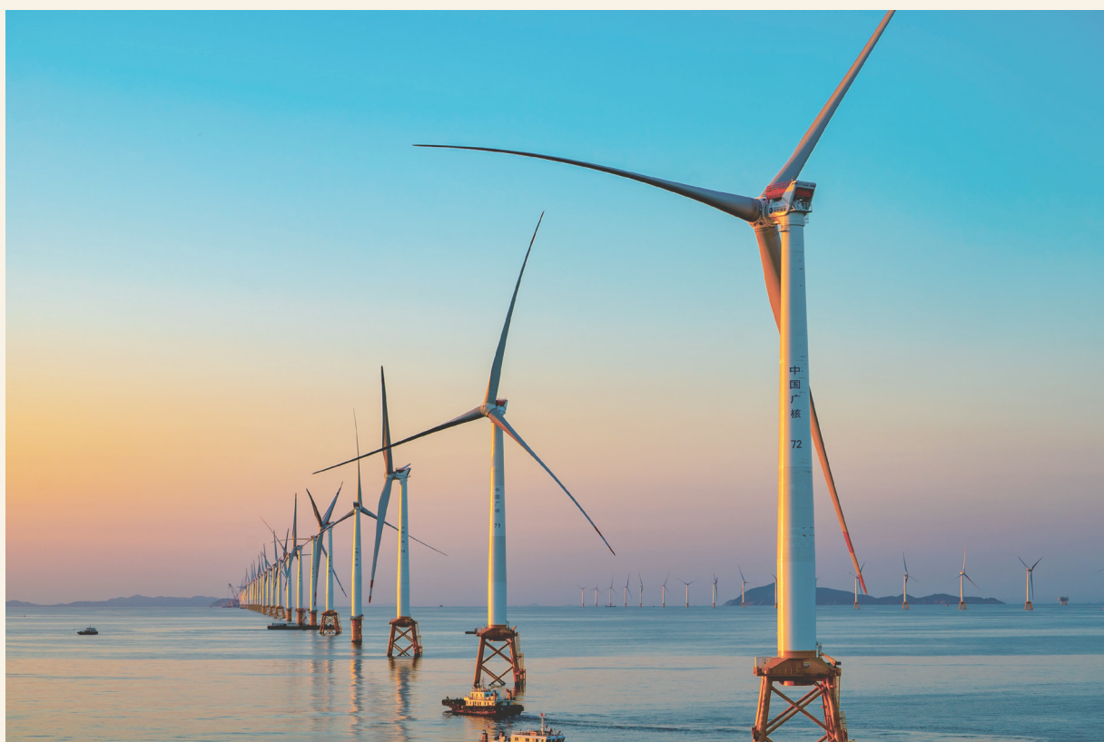
廣東汕尾甲子海上風電項目
