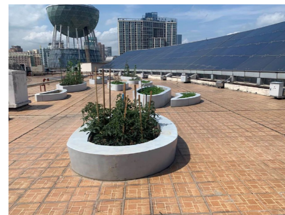
Green roof 樓頂綠化
