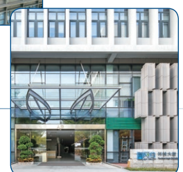
TECHNOLOGY BUILDING 2 科技大廈二期
