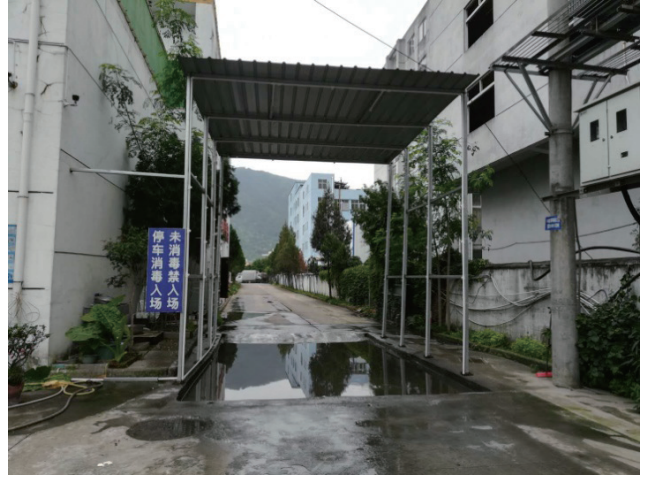
進入屠宰場的運料車的消毒水池
