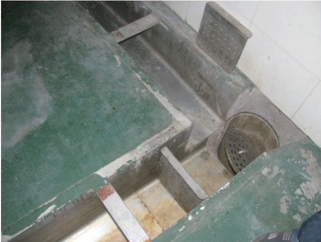
屠宰場內排放廢水的排水溝
