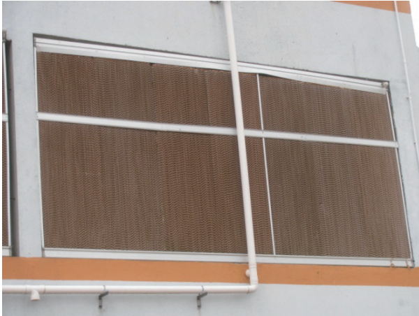
外牆開口處安裝蒸汽冷卻板
