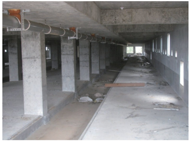
養豬欄內排水渠結構
