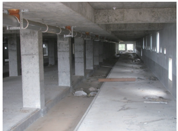
養豬欄內排水渠結構
