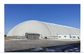
2019年9月,公司承建的荆门石化油品升级改造储煤场工程正式投入使用,该项目占地面积24200平方米,项部采用全透光膜材,白天膜内完全采用自然采光,大幅降低了照明能耗,在满足环保要求的同时有效降低了运营成本。
